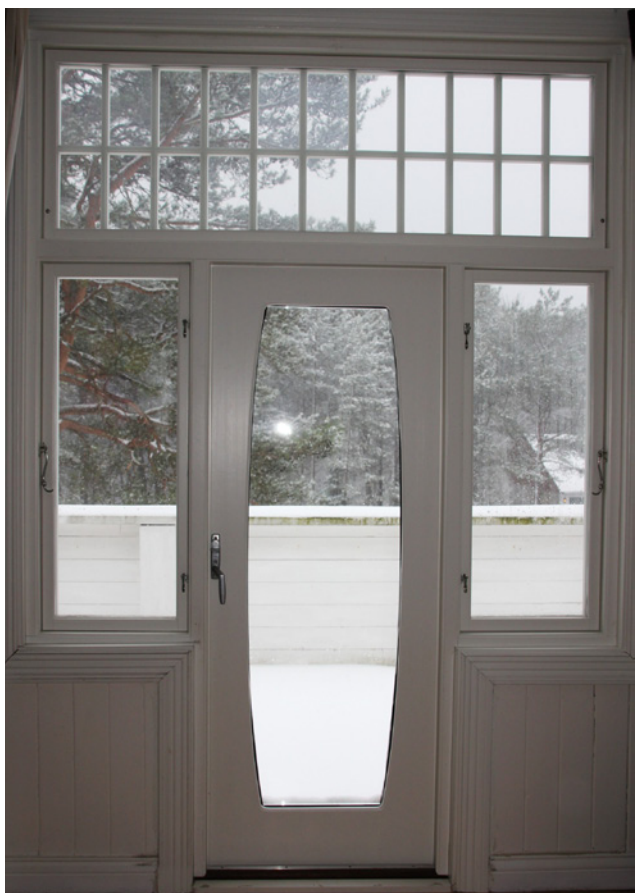
Balkongdør med buet glass, overfelt i koblet utførelse, og sidefelt med isolerglass
