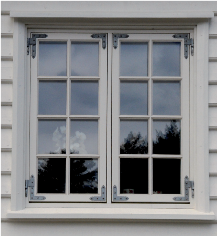
Kobla vindu med 1800 talls hengsler og hjørnejern, og redusert bunnklaring.
