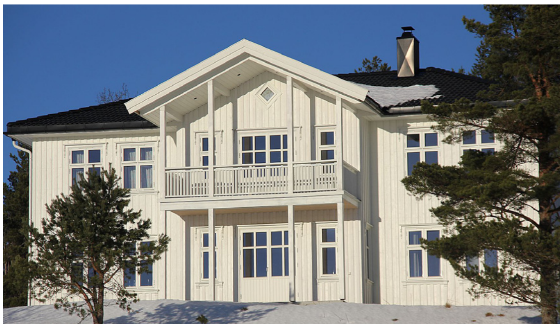
Losholt / krysspостvindu og balkongdør med gjennomgående sprosser.
