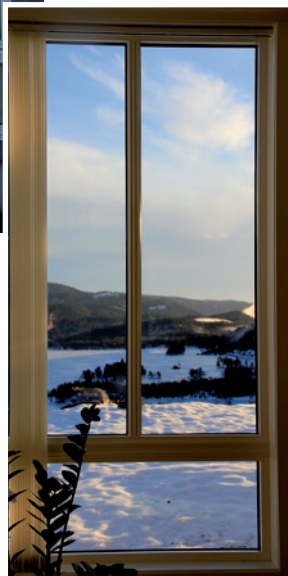
Isolerglass vindu med gjennomgående sprosser
