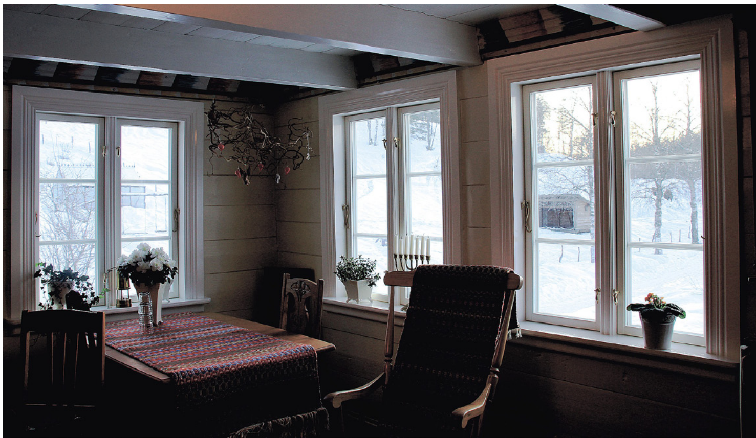
Kobla vindu levert med karm tilpasset slett utforing, 1800 talls profil og «gammelt» glass i utvendig ramme.
