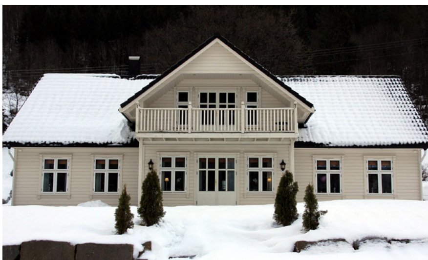
Balkongdør og krysspostvindu med energiglass
