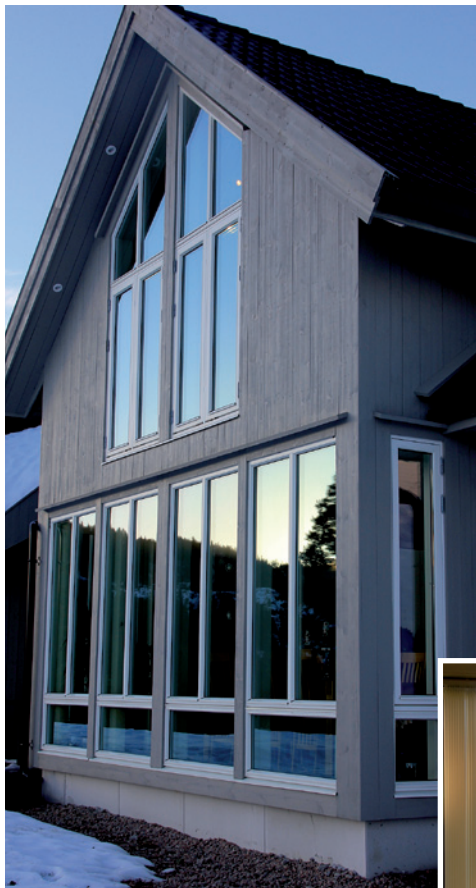
Isolerglass vindu med gjennomgående sprosser
